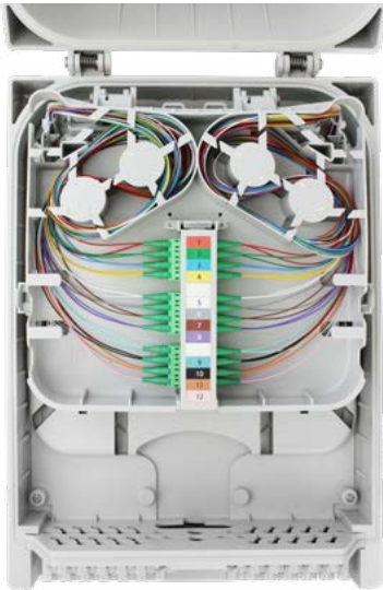
MDU-XL-Wallbox Patchbereich mit beispielhafter Konfektionierung
